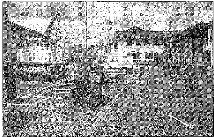
Les ouvriers s'activent pour terminer les travaux du centre village de Montrequienne avant la fête patronale. Photo RL
